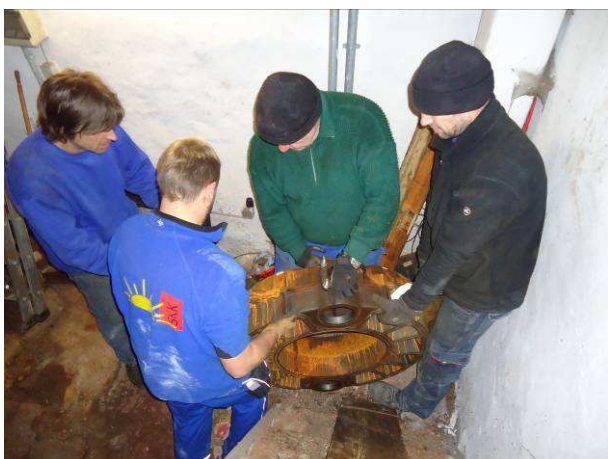
Über eine Tonne wiegt der gusseiserne Kessel. Er musste aus vier Teilen zusammengebaut (genippelt) werden.
