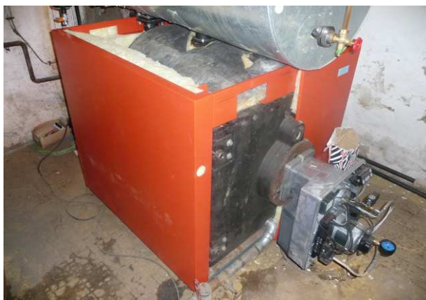
Der neue Niederdruck-Kessel. Er erzeugt heißen Wasserdampf, der mit weniger als 1 bar in den Leitungen fließt.
