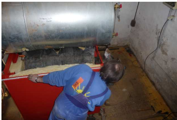
Der neue Niederdruck-Kessel. Er erzeugt heißen Wasserdampf, der mit weniger als 1 bar in den Leitungen fließt.
